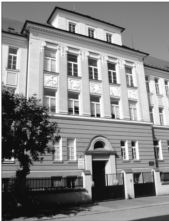
Budova školy v Hálkově ulici
